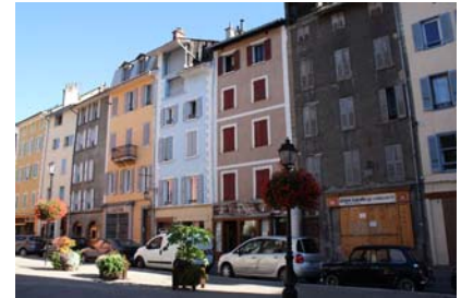
Rénovation du bâti dans la bastide, présence de commerces et équipements
