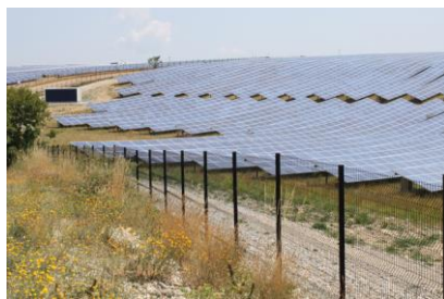
Parc Photovoltaïque (Les Mées)
